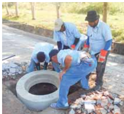
Cambio de casquete de cemento en Las Cascadas.
