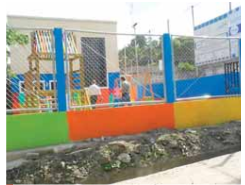
Construcción del Kinder en la INFOP y Parque el Mirador.
