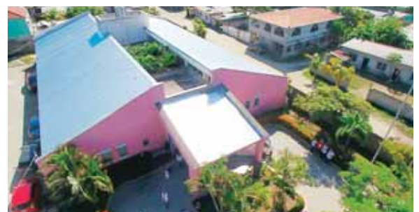
Techado de la Cliper y pavimentación de calle principal en la colonia López Arellano.
