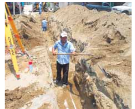
Trabajos en el sistema de alcantarillado sanitario.
