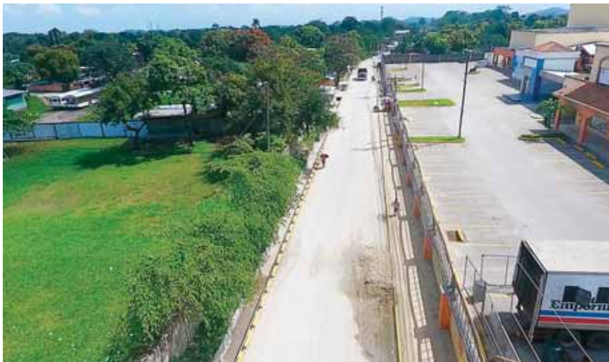
Construcción del anillo de descongestionamiento vial.
